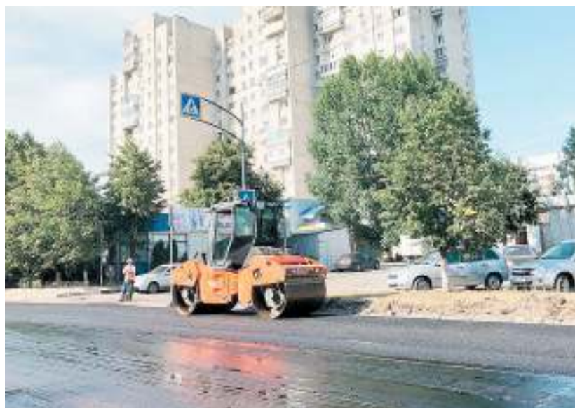
На проспекте Ульяновском ведется демонтаж бортового камня и фрезерование дорожного полотна на одной из проезжих частей, а на второй уже уложен выравнивающий слой
