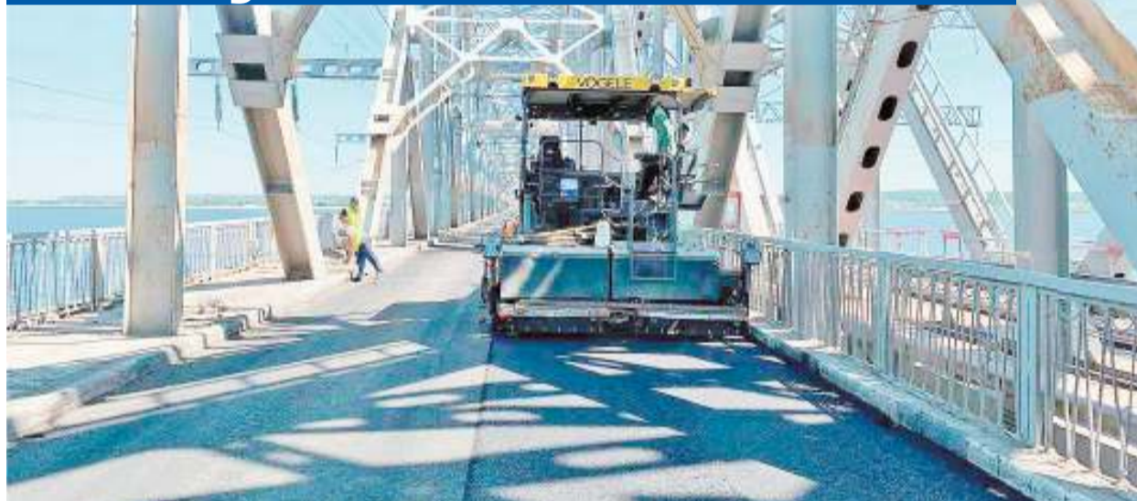
На Императорском мосту были выполнены работы по устройству деформационных швов и щебеночно-мастичного асфальтобетона протяженностью около 2 км
