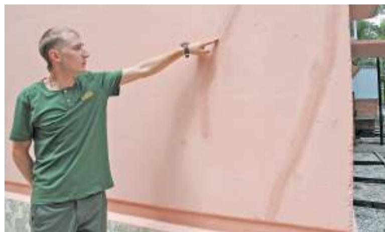
Дмитрий ЛОГИНОВ: «Помимо непосредственно заделки трещины, фасад еще будет стянут стальным тросом по периметру, чтобы дополнительно укрепить конструкцию»
