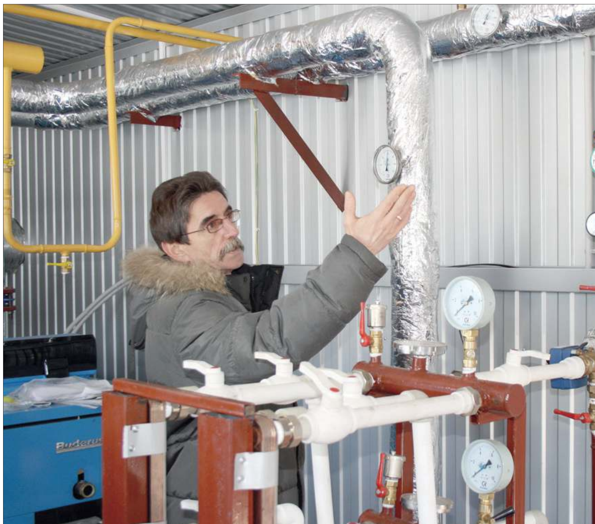
Последним профессиональным увлечением БУКИНА был спроектированный и собранный под его руководством первый мобильный отопительный пункт. По сути, это котельная на колесах, которая наверняка еще долго будет использоваться другими поколениями специалистов ЖКХ при чрезвычайных ситуациях
