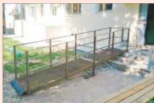
Ведется установка пандуса в доме №25 по ул. 40 лет Октября - в рамках капремонта
