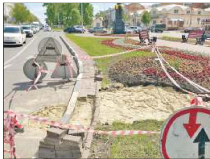
13 июня начинается капитальный ремонт теплотрассы на ул. Гончарова. Движение по дороге будет ограничено одной полосой
