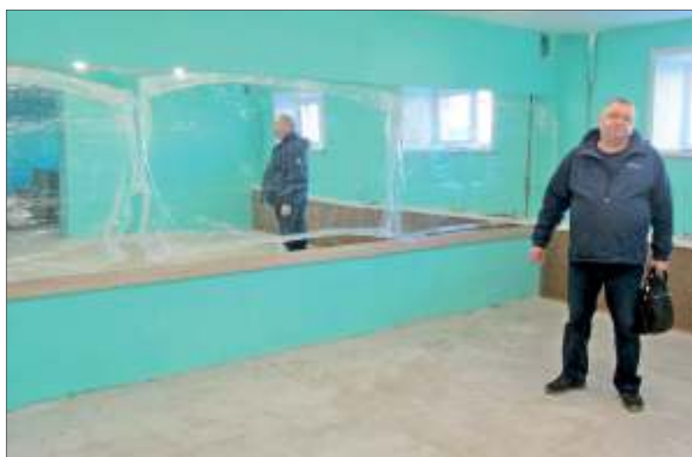
Владимир ВАСИЛЬЕВ показывает помещение для секции кикбоксинга, где завершается ремонт. Ребята попросили одну стену сделать зеркальной - это нужно для тренировок
