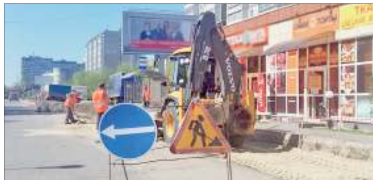
После завершения ремонтной кампании этого года 55,5% автодорог города будут приведены в нормативное состояние. Для сравнения: по итогам 2017 года было почти 50%, 2016 года - менее 45%
