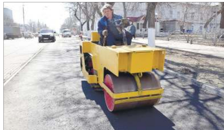
Весь карточный ремонт в Ульяновске планируют завершить до конца мая
